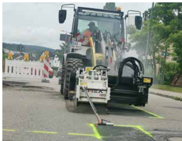
Das Bild zeigt die Fräse im Einsatz.
